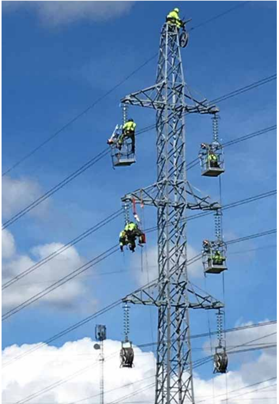
110 kV liini ehitamine Pärnumaal
